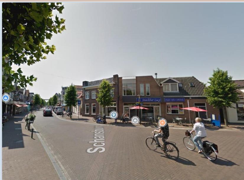
Foto van de hoofdstraat, bij de T-splitsing met snackbar Lucy op de achtergrond.
